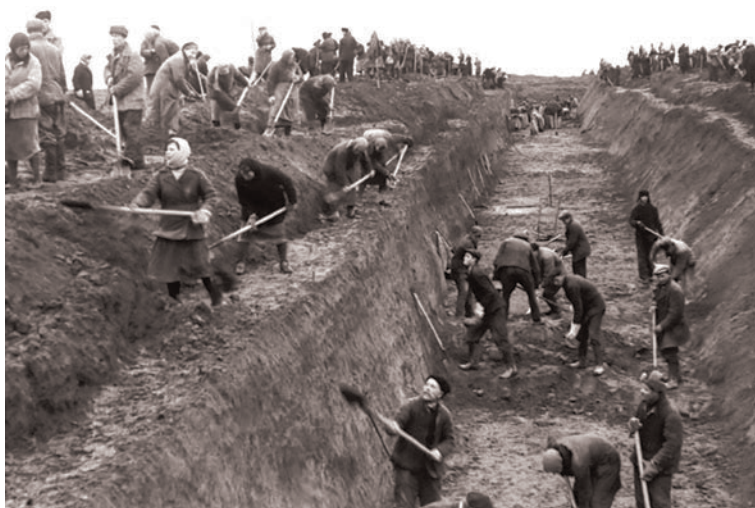
Строительство противотанкового рва
