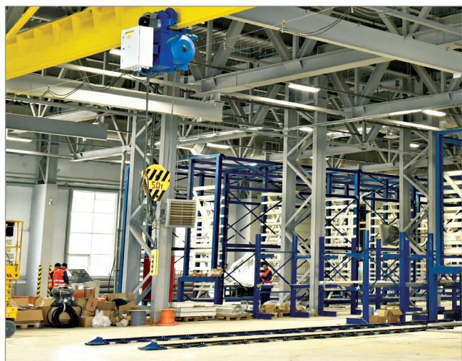
► Монтаж автоматизированной системы хранения крупнотоннажных материалов и заготовок
