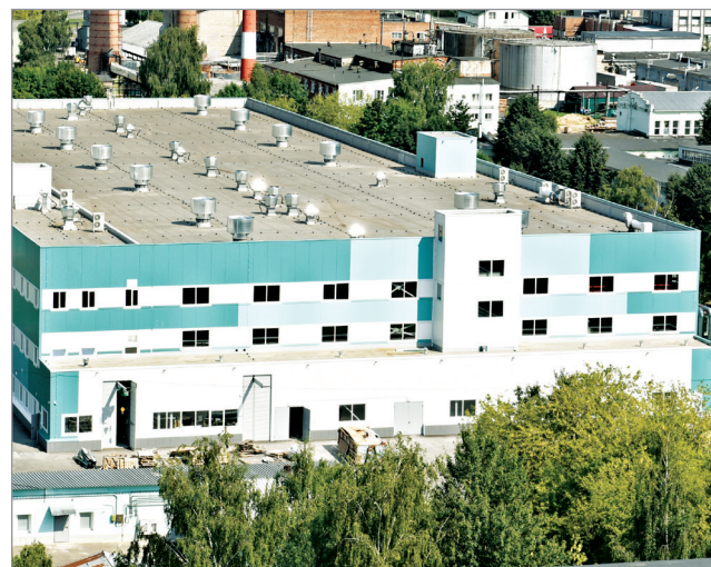
► Общий вид заготовительно-складского комплекса
